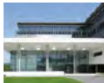
12 Büro- und Geschäftshaus «Hillsite», Schwalbach am Taunus/DE
