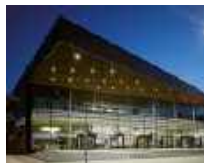
60 Vogtlandhalle (Stadthalle), Greiz/DE
