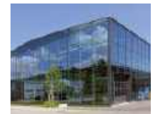
66 Werkhalle Glas Trösch, St.Gallen/CH
