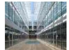
18 Universität Lausanne «Géopolis», Lausanne/CH
