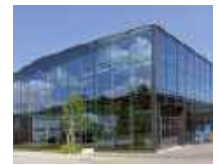
66 Werkhalle Glas Trösch, St.Gallen/CH
