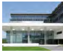
12 Büro- und Geschäftshaus «Hillsite», Schwalbach am Taunus/DE
