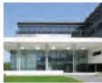
12 Büro- und Geschäftshaus «Hillsite», Schwalbach am Taunus/DE
