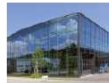
66 Werkhalle Glas Trösch, St.Gallen/CH
