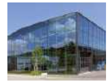
66 Werkhalle Glas Trösch, St.Gallen/CH
