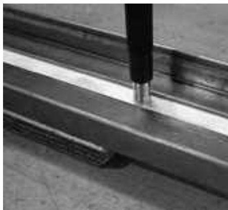
Einschlagen des Belüftungsrohres Enfoncement du tube de ventilation Driving the ventilation tube home
