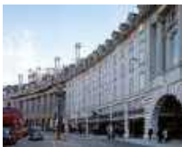
9 Gebäudesanierung, Regent Street, London/GB
