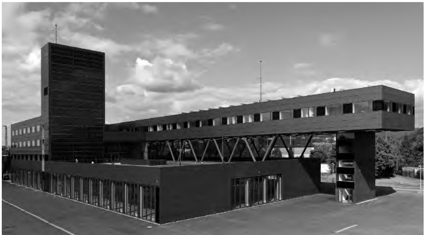
Feuerwehrwache Heidelberg, Heidelberg/D
