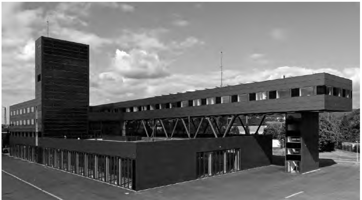
Feuerwehrwache Heidelberg, Heidelberg/D
